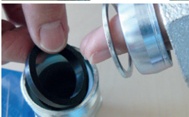
Bild 4: Vorlegering auflegen, Klemmring auflegen, Konusmutter aufschrauben
