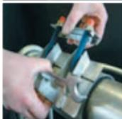
Der Rest funktioniert per Hebelwirkung: Man drückt die Unterkante der Schelle und den Maulschlüssel mit einer Hand zusammen und kann nun mit der anderen Hand ganz bequem die bewegliche Haltebrücke auf der Oberkante der Edelstahlschelle platzieren. Muttern festziehen, fertig!
