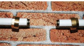
Rohrinnen-Ø mittels Messdorn ermitteln. Passende Stützkörper bis zum Anschlag eindrücken. Überwurfmuttern über die Rohrenden schieben.
