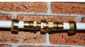
Ausgleichsarmatur in Richtung der Rohrenden auseinanderschieben, bis die Verschraubungsenden auf der Klemmhülse einrastet.
