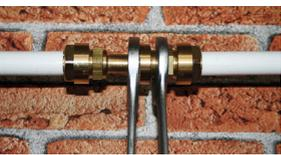
Abschließend die mit einer Rille markierten Mittelmutter mit der Ausgleichsarmatur fest verschrauben.
