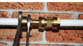
Überwurfmuttern aufschrauben und so lange anziehen bis die Klemmhülse max. 1–2 mm aus der Überwurfmutter hervortritt. Hier ist zu vermeiden, dass sich das Rohr mitdreht.
