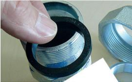
**Bild 3:** Den neuen EPDM Dichtring aus der Verpackung nehmen und in die Dichtkammer einlegen.
